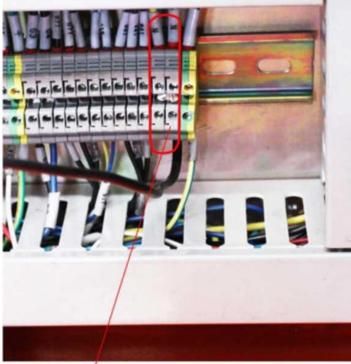
нулевой кабель источника питания должен быть соединен с каждой из этих клемм
